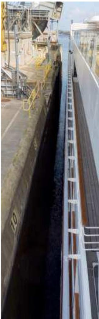
Vor der zweiten Schleuse müssen wir kurz warten, denn ein mit Getreide beladener Frachter wird grade „herabgelassen“ und verlässt dann die schmale Schleusen-kammer. Die mit 244 x 24 Metern genormte Schleusen-kammern brauchen knapp 80.000 Kubikmeter Wasser um unser Schiff die jeweils ca. 12 Meter emporzuheben und funktionieren rein mit der Schwerkraft – das Wasser aus den oberen Seen fließt einfach durch die Schleusenstrecke abwärts, dazu bedarf es keiner Pumpen.
