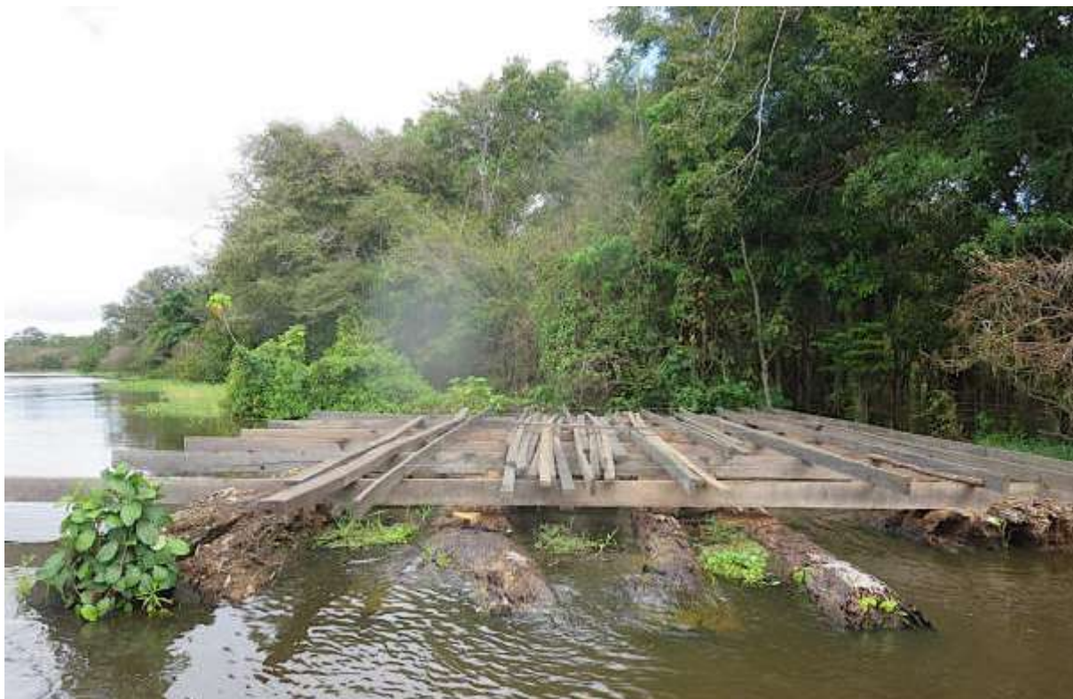
Saubere Zimmermannsarbeit und alles im Lot: bei Cuxiu Muni wird das Floß für ein schwimmendes Haus gebaut
