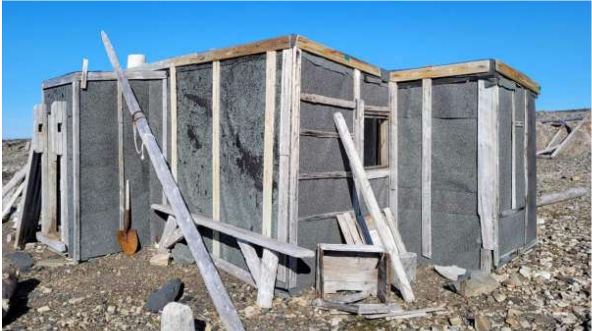
Die Ritterhütte von außen
