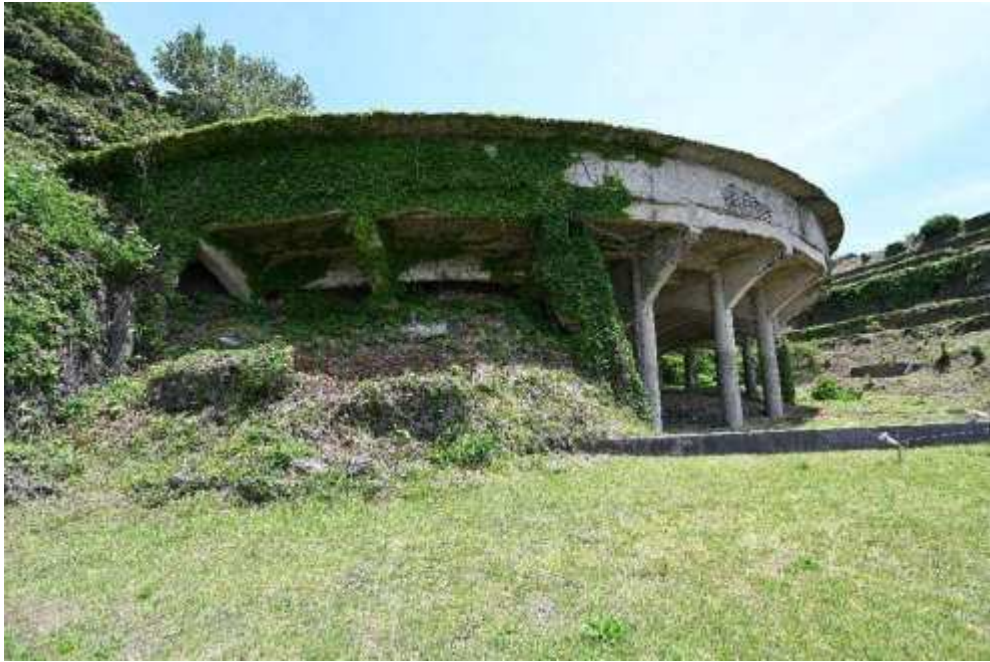
Floatationsanlage der ehemaligen Mine
